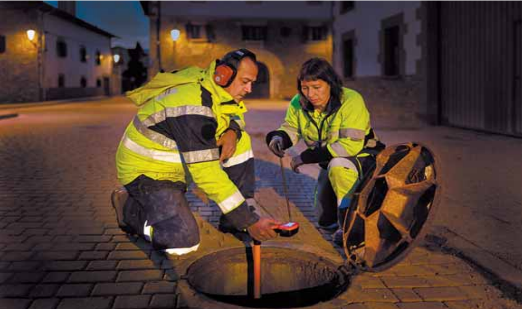
Dos trabajadores del Centro de Mantenimiento de Redes e Instalaciones de la MCP con un equipo localizador de fugas de agua.
