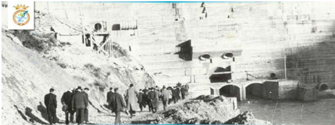
Obras de construcción del pantano de Yesa.
