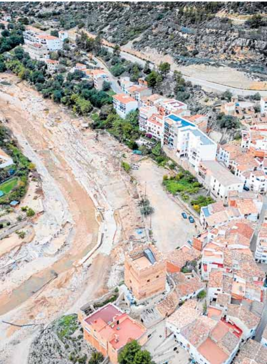
Vista del Turia a su paso por Sot de Chera tras la dana. JL BORT
